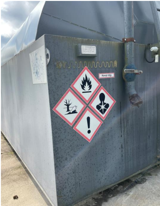
Kuva 38. Valuma-altaallinen öljysäiliö.
