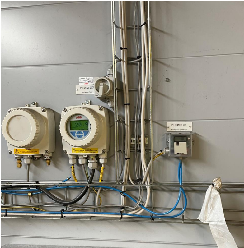
Kuva 26. Savukaasun jäännöshappimittaus, ABB
