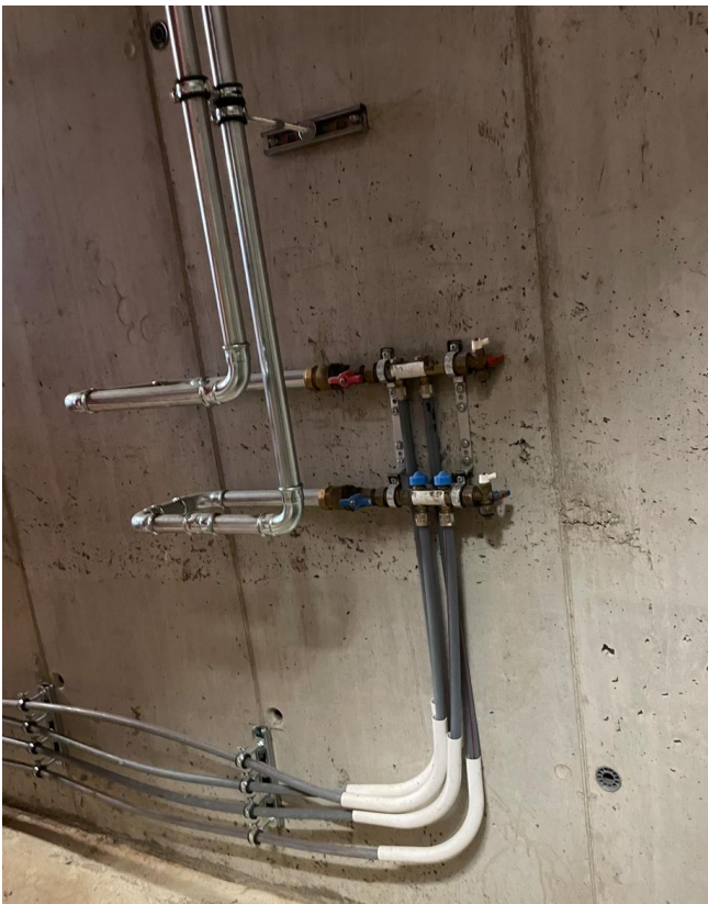
Kuva 5. Pohjalämmitysputkiston jakotukki.
