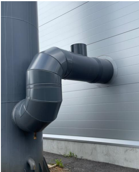
Kuva 29. Savupiippu, savukanava ja päästömittausyhteet
