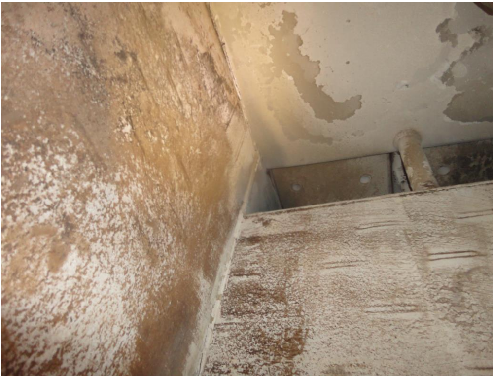
Kuva 12. Tulipesän yläosa arinan päältä kuvattuna, josta savukaasut kulkeutuvat kohti konvektipintoja
