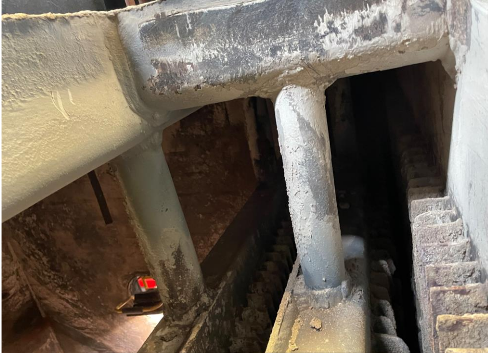
Kuva 21. Konvektiopintojen ensimmäiset vedot. Vasemmalla alhaalla näky arinalle, katso kuva 12.
