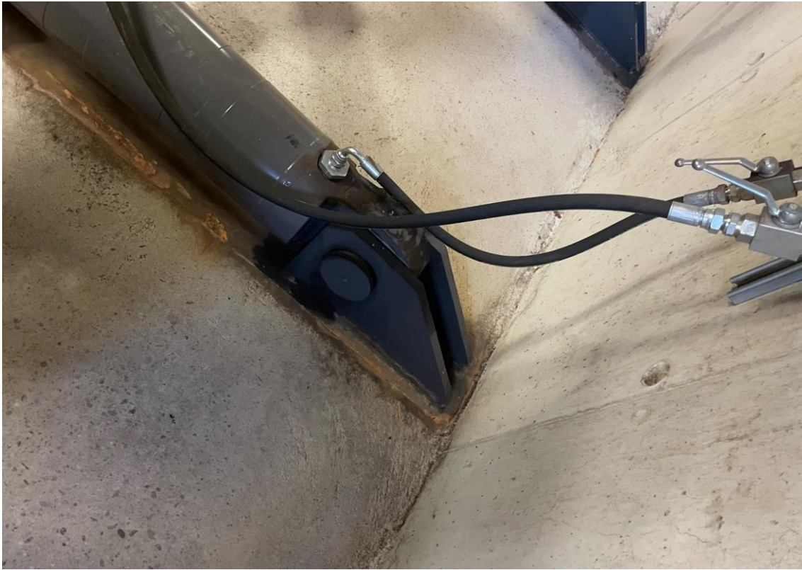
Kuva 2. Hydraulisylinterin tartunta betonirakenteeseen.
