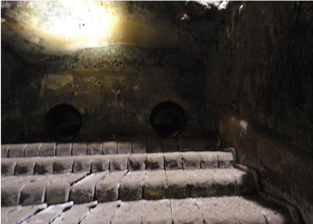
Kuva 19. Kuvaussuunta arina yläosaan, jossa stokeriruuviaukot. Kuvan 16 "lipan" kohta on valonheitinkohdan yläpuolella.
