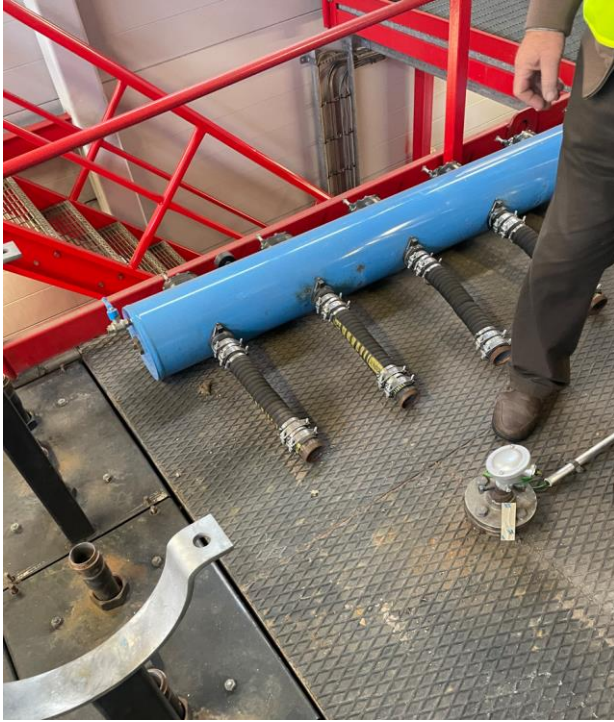
Kuva 28. Paineilmanuohousjakotukki.
